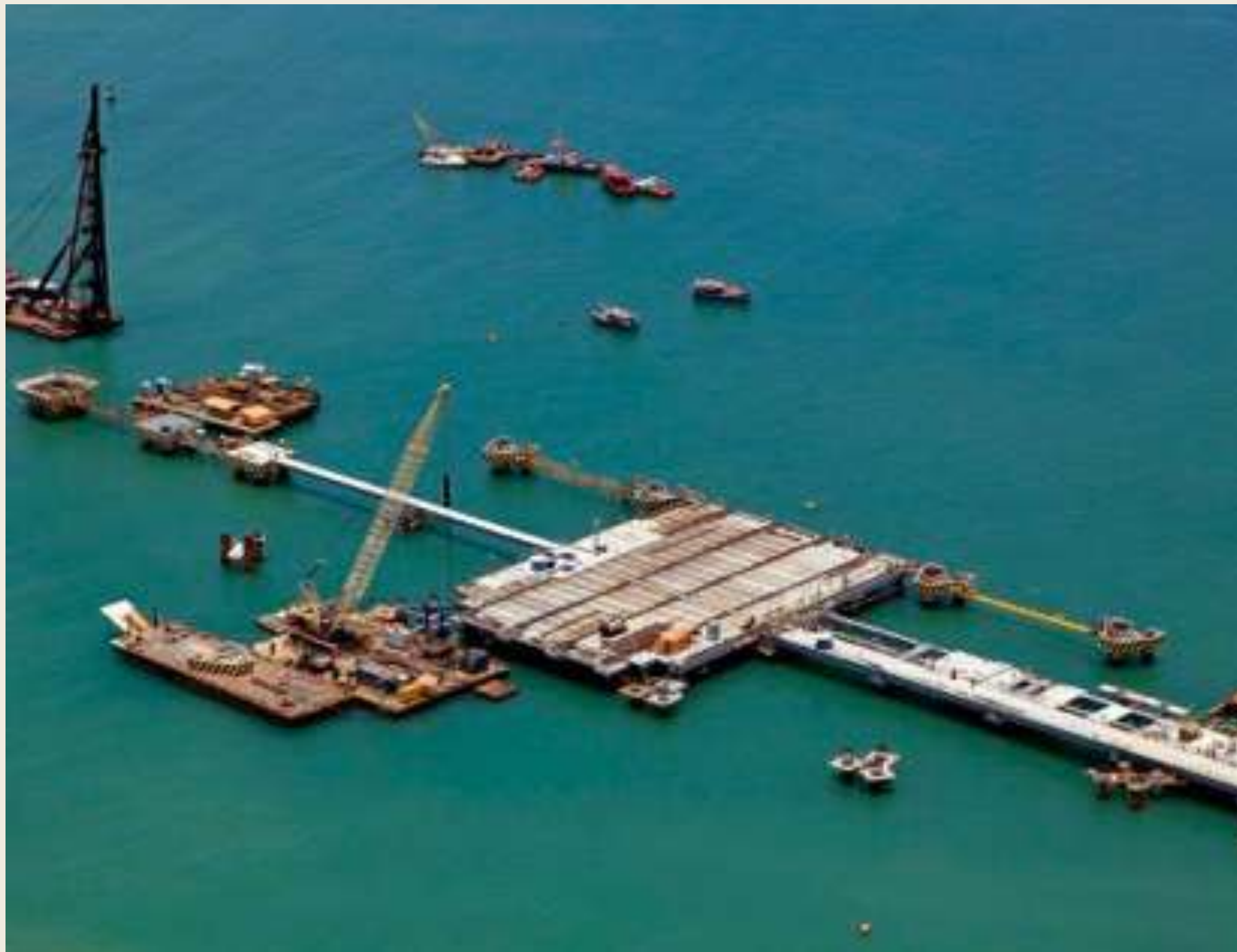
PLATAFORMA TERMINAL AQUAVIÁRIO BARRA DO RIACHO ES - PETROBRAS
